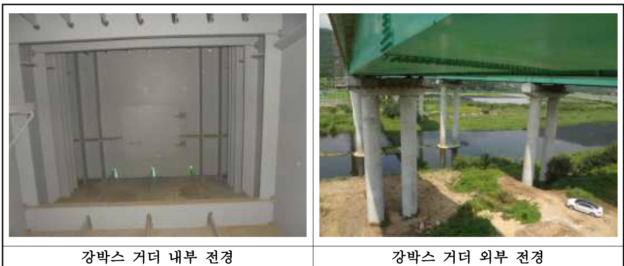
【사진 3.2.3】 강박스 거더 전경(대구)
