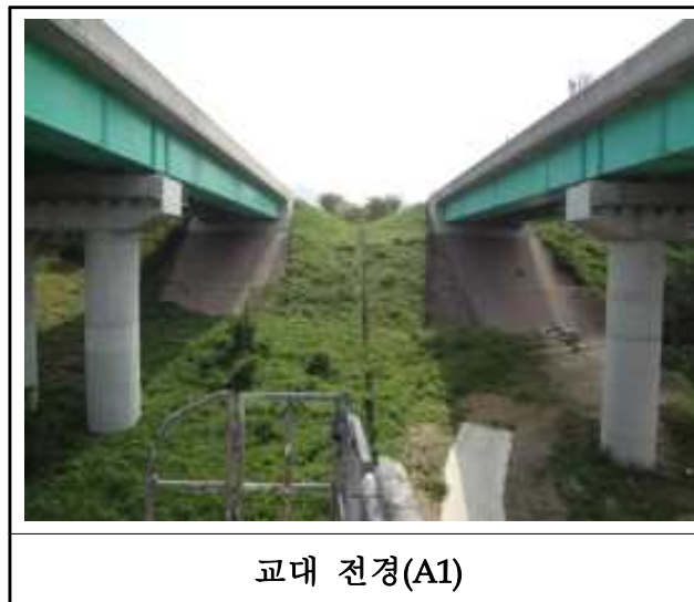
【사진 3.2.8】 교대 전경(대구)
