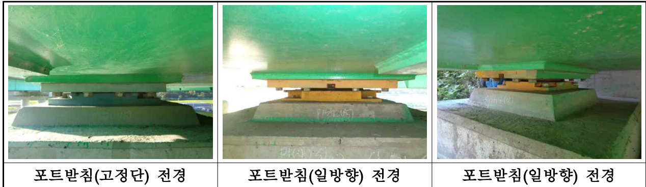
【사진 3.2.13】 교량받침 전경(대구)
