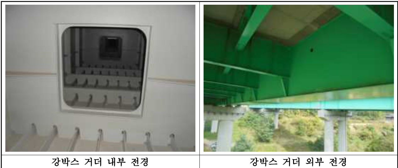
【사진 3.3.3】 강박스 거더 전경(부산)
