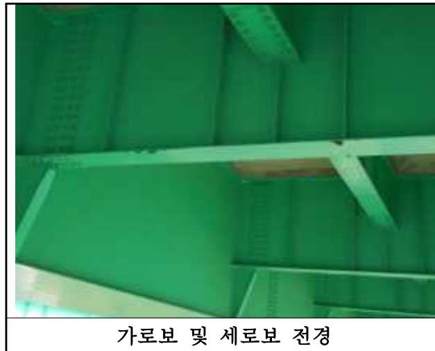
【사진 3.3.6】 가로보 및 세로보 전경(부산)
