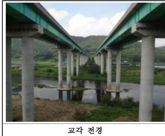
【사진 3.3.10】 교각 전경(부산)
