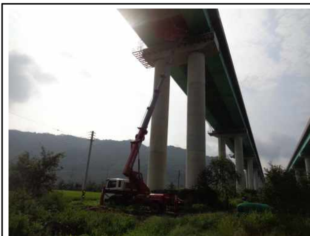
고소작업차를 이용한 조사
