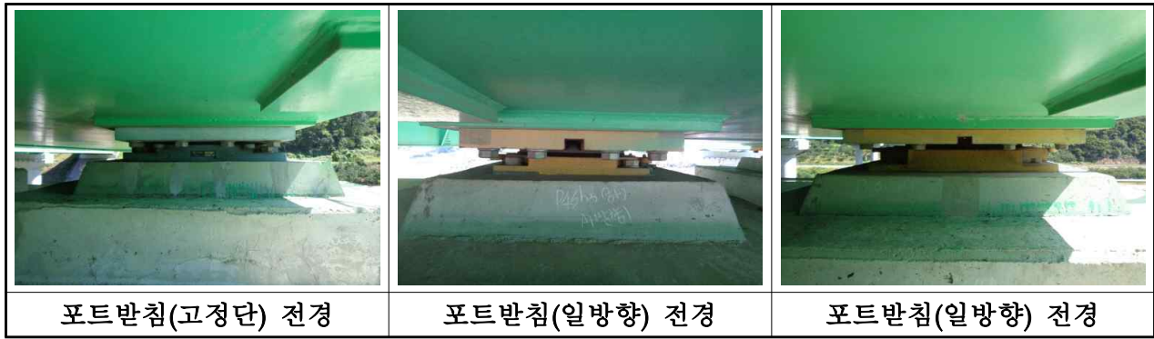
【사진 3.3.13】 교량받침 전경(부산)
