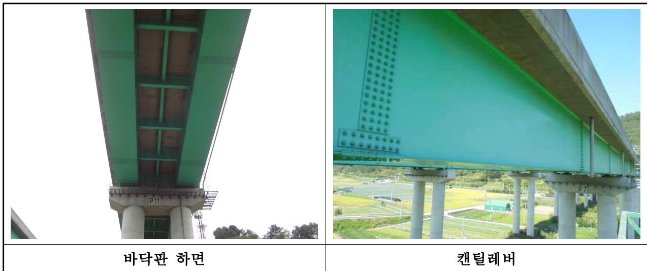
【사진 3.2.1】 바닥판 전경(대구)
